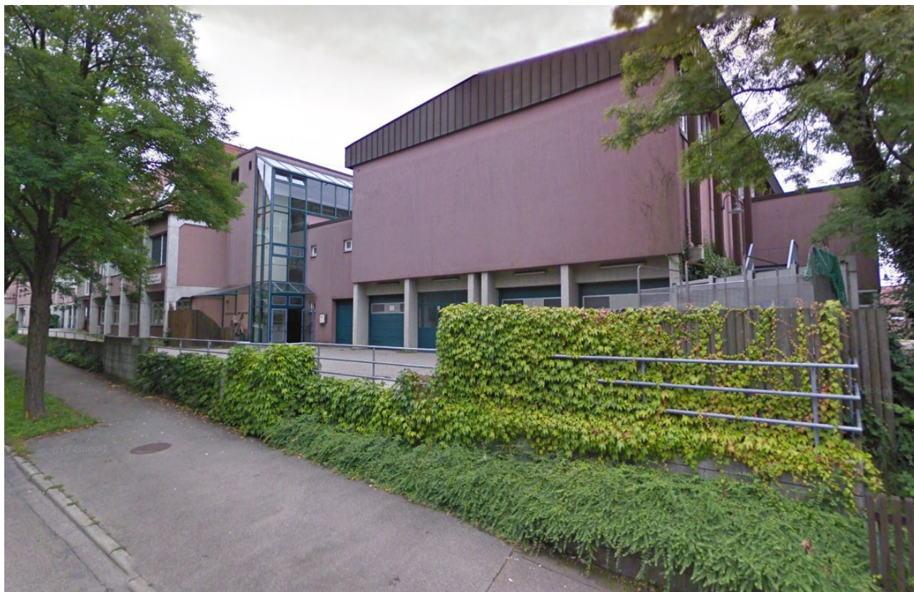
Schon abgerissen: Humane Anbauten der alten Blindenanstalt am Kräherwald
