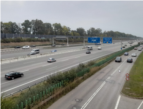
Autowahnsinn: 12 Fahrspuren auf Höhe Unteraichen
